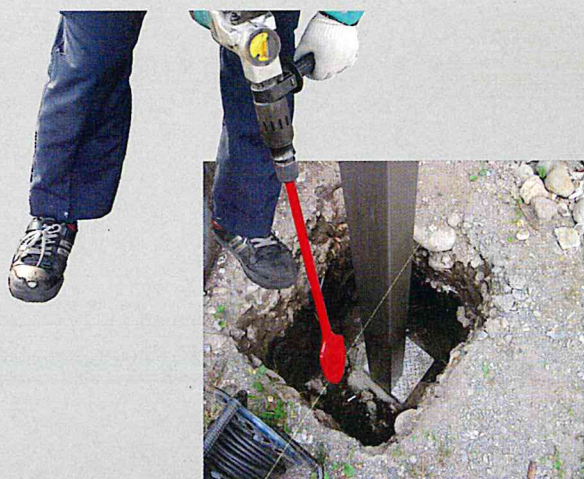
カーポート支柱穴掘り
